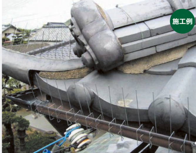
▲雨樋にエコクリップ設置
