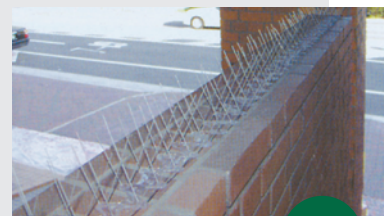
▲鳥の隙間への侵入を防ぎます。
